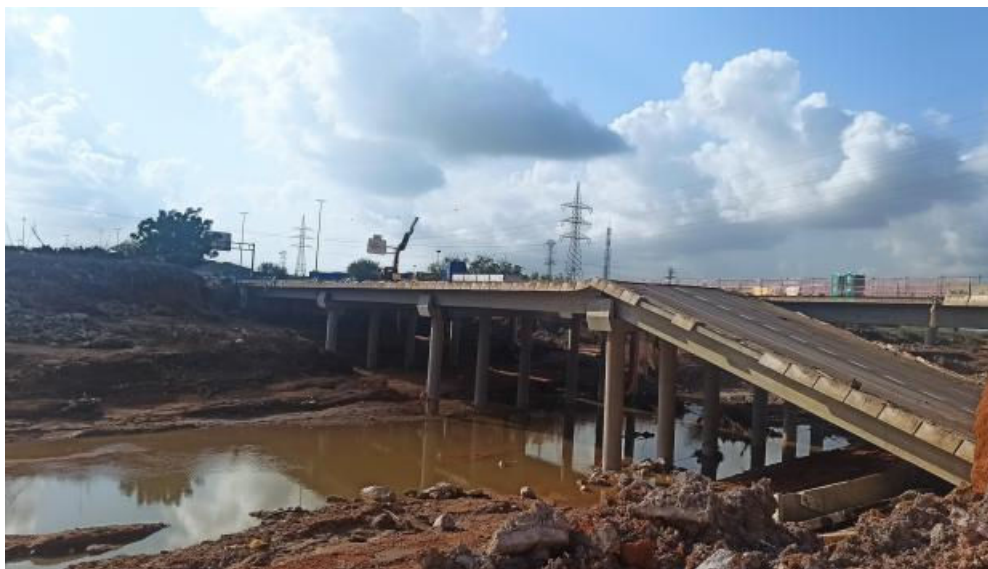
Imagen del viaducto de la CV-33 sobre el Barranco del PoyoEl Debate
