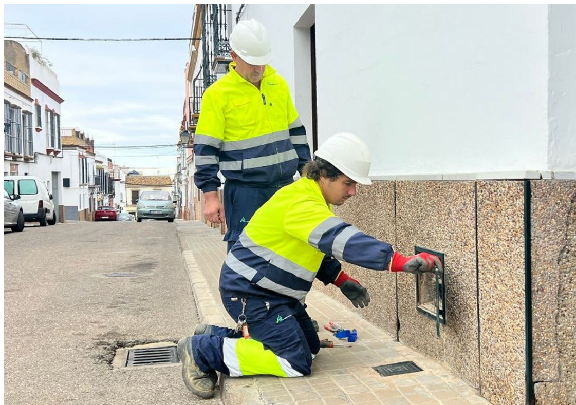
Dos fontaneros trabajan en una de las localidades afectadas Aguas del Huesna
